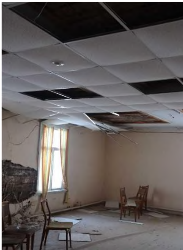
Точка фотофиксации 29. Вид на помещение 2 этажа (северо-восточный угол), в деревянном пристрое здания.
