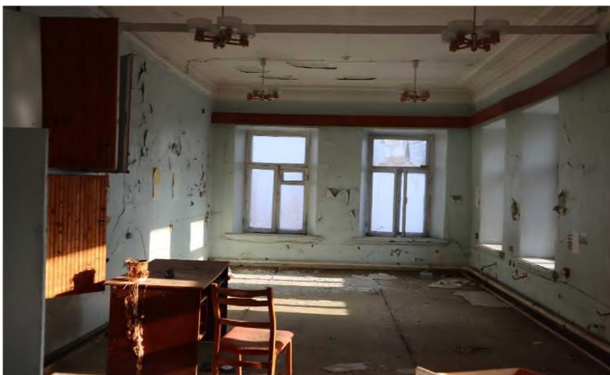
Точка 24. Вид на помещение 2 этажа (юго-западный угол) правого крыла
