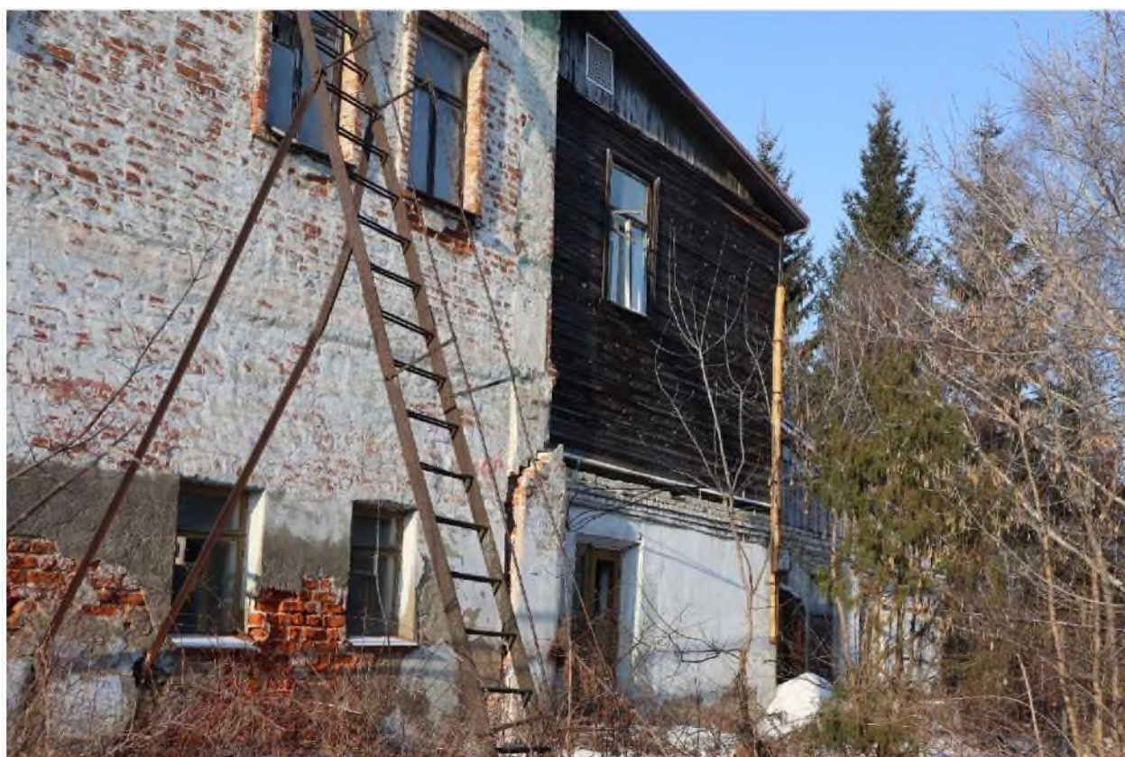
Точка фотофиксации 8. Вид на восточный фасад с юго-востока (одноэтажный и двухэтажный пристрой).
