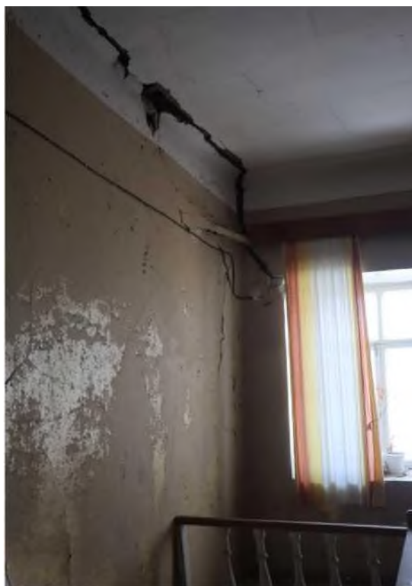
Точка фотофиксации 30. Вид на помещение лестничной площадки 2 этажа здания.
