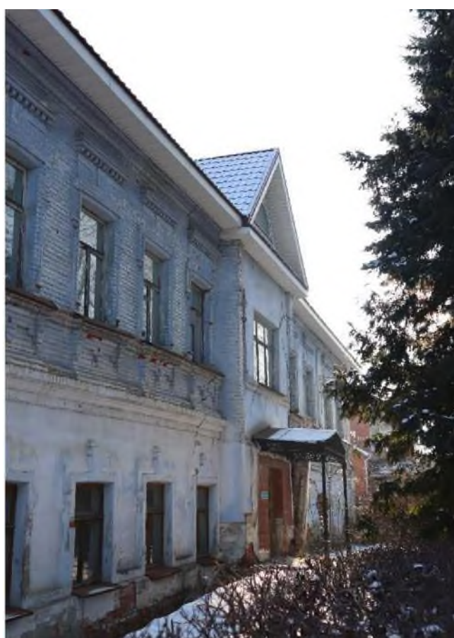
Точка фотофиксации 4. Вид на западный фасад с северо-запада.
