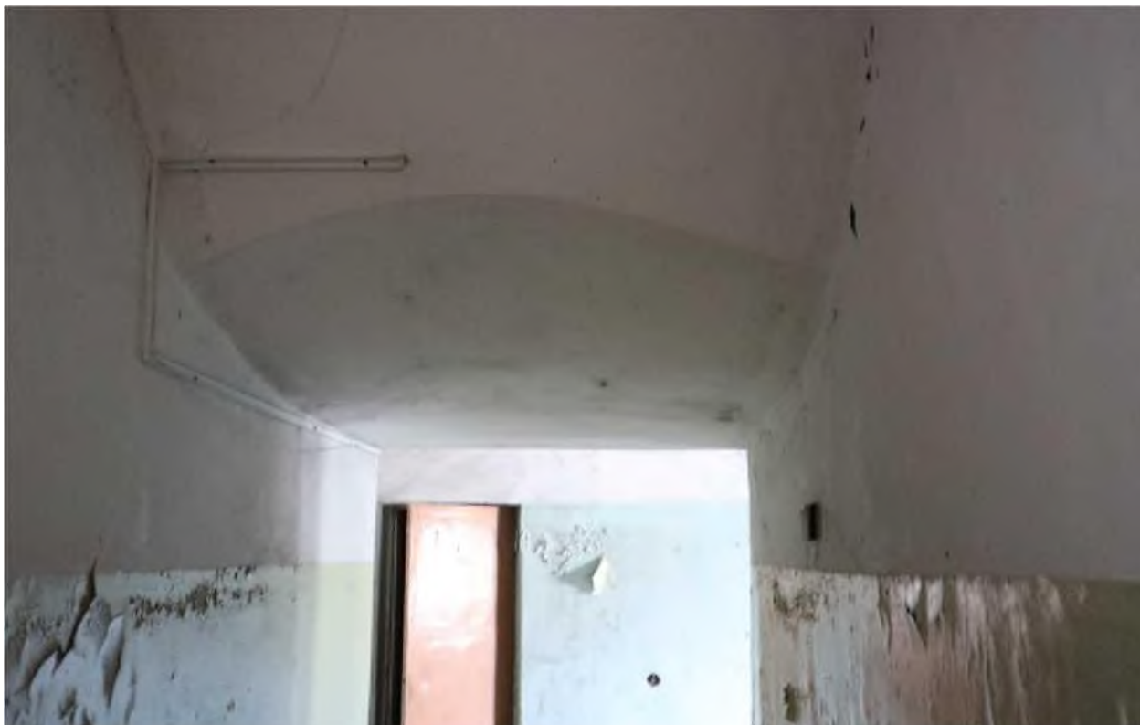
Точка фотофиксации 19. Вид на помещение коридора, расположенного на 1 этаже по восточной стороне правого крыла здания.
