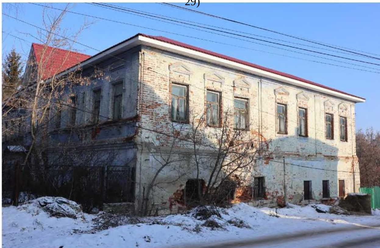
Точка фотофиксации 1. Вид на западный и южный фасады
