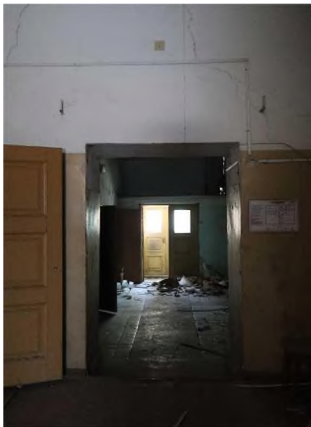
Точка фотофиксации 15. Вид на коридор первого этажа, ведущий к запасному выходу.
