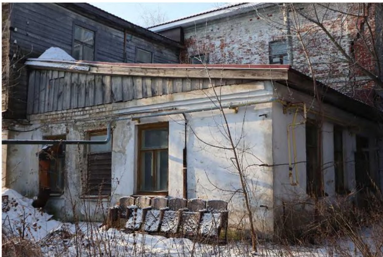
Точка фотофиксации 7. Вид на северный и восточный фасады с северо-востока (одноэтажный пристрой).
