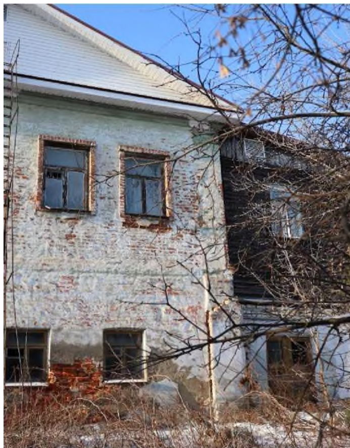
Точка фотофиксации 9. Вид на восточный фасад с востока.
