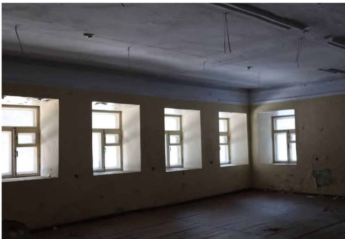
Точка фотофиксации 16. Вид на помещение 1 этажа (северо-западный угол) левого крыла здания.
