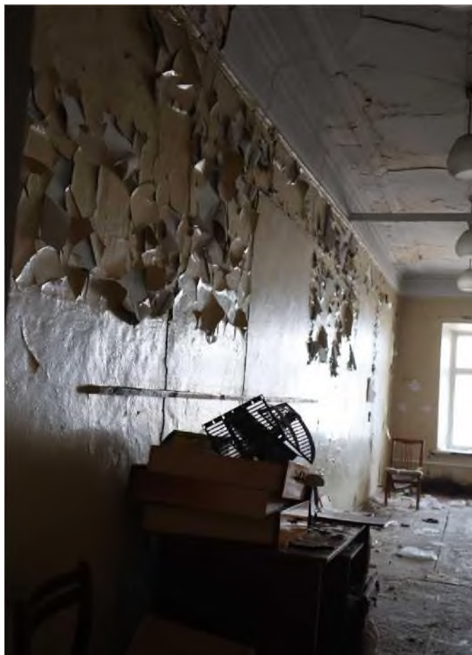
Точка фотофиксации 23. Вид на помещение 2 этажа западной части правого крыла здания.
