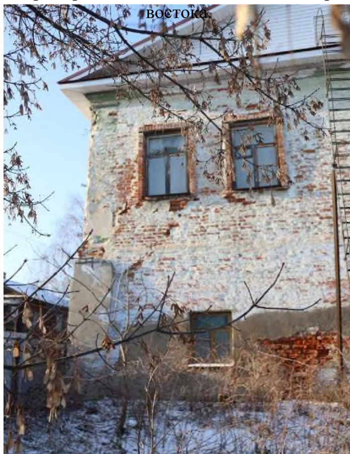
Точка фотофиксации 10. Вид на восточный фасад с северо-востока.
