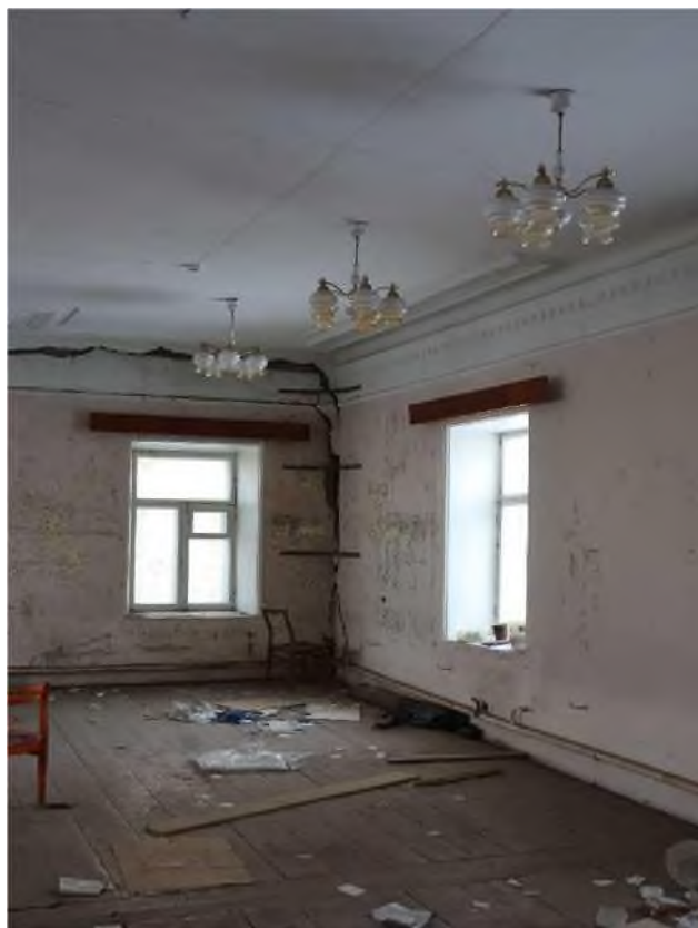
Точка фотофиксации 21. Вид на помещение 2 этажа (северо-восточный угол) левого крыла здания.
