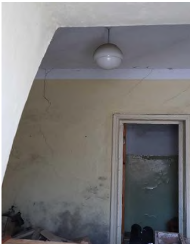
Точка фотофиксации 17. Вид на помещение 1 этажа по восточной стороне правого крыла здания.
