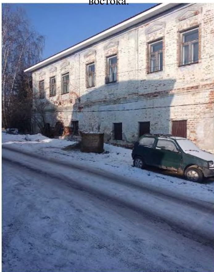
Точка фотофиксации 12. Вид на южный фасад с юго-востока.
