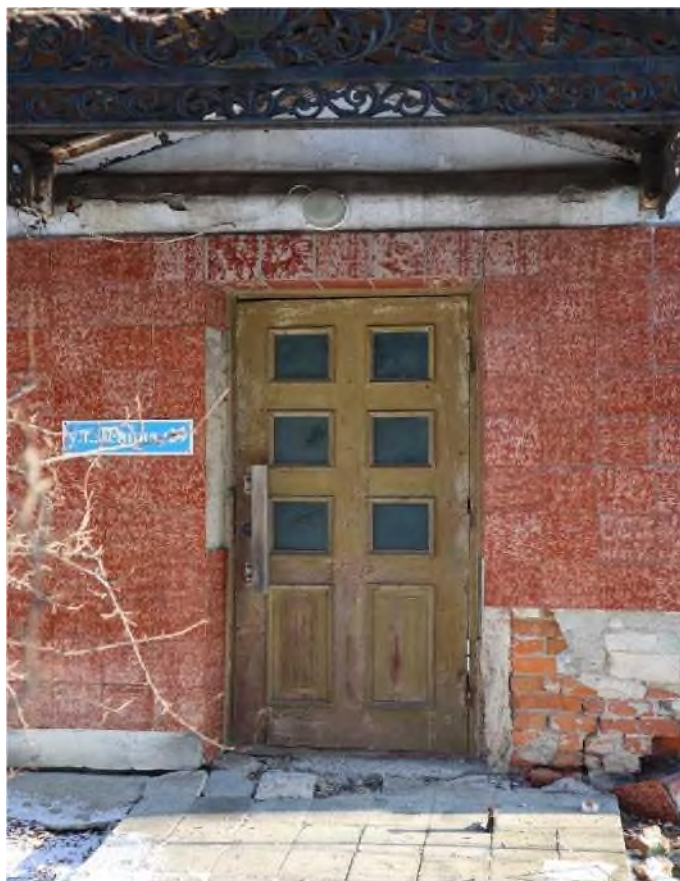
Точка фотофиксации 13. Вид на главный вход в здание
