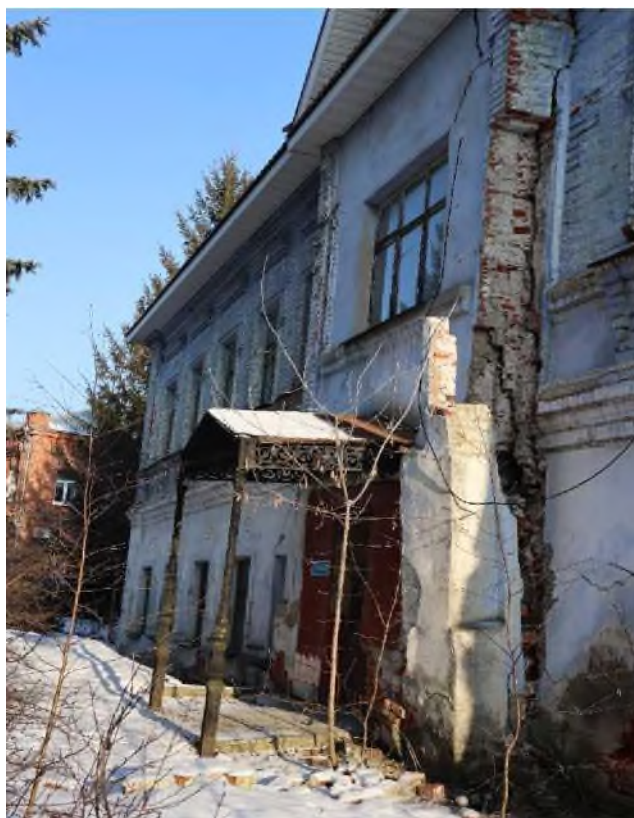
Точка фотофиксации 3. Вид на западный фасад (главный вход и левое крыло) с юго-запада.
