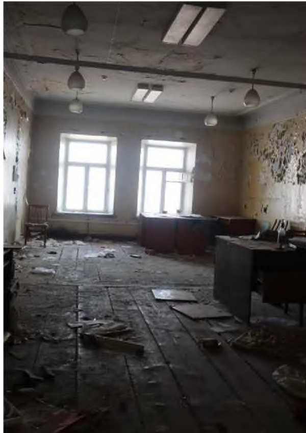
Точка фотофиксации 28. Вид на помещение 2 этажа (восточной части) правого крыла здания.
