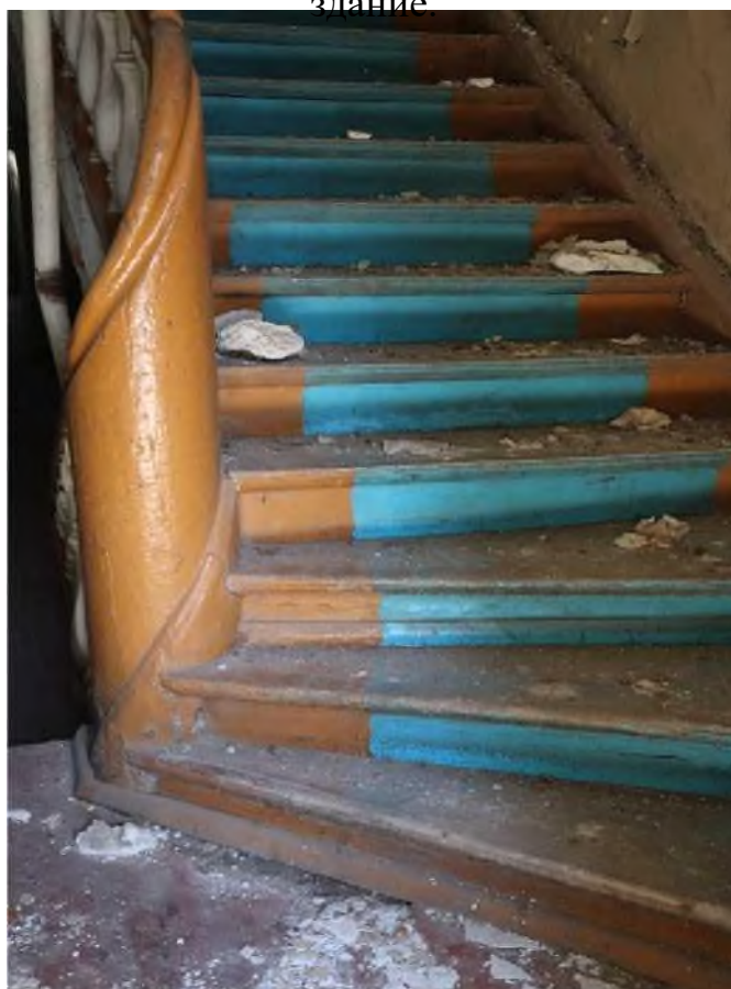
Точка фотофиксации 14. Вид на лестницу ведущую на второй этаж.
