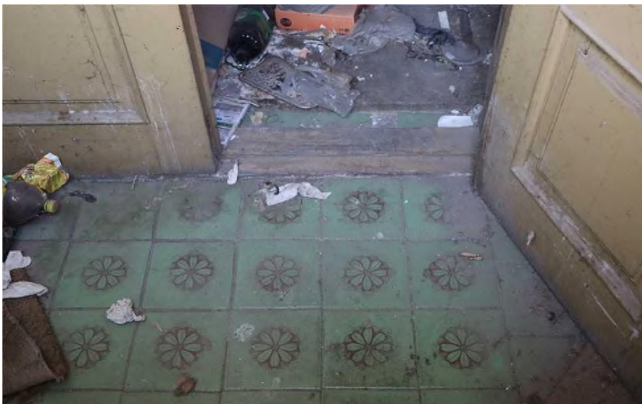
Точка фотофиксации 20. Вид на покрытие пола первого этажа в помещении у чёрного входа со стороны восточного фасада здания.
