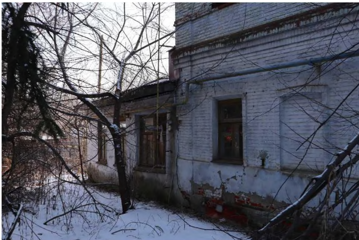
Точка фотофиксации 6. Вид на 1 этаж северного фасада с северо-запада.
