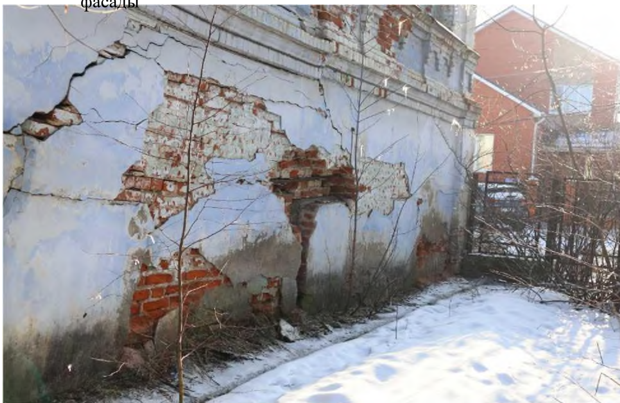
Точка фотофиксации 2. Вид на 1 этаж западного фасада (правое крыло).
